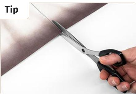
Kort de textielpanelen vóór de montage in tot de gewenste lengte.
